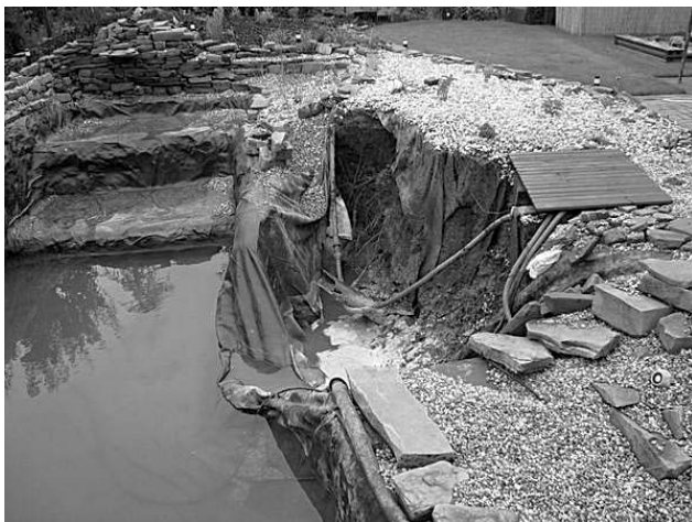
Přívalový déšť způsobil poškozeným spoustu starostí ... toto jezírko už moc parády nenadělá. Foto: Petr Hasil
