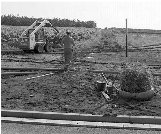
V podnikatelské zóně „Za tratí“ byla zahájena výstavba budovy firmy Berendsen.
